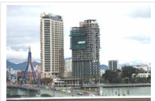
ダナン市内でも見られる大型物件の建設現場
