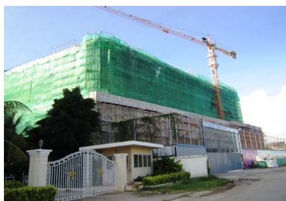
建設中のイオン・モール
