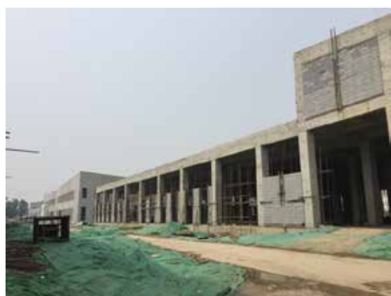
河北省にある建設中の工業園區
